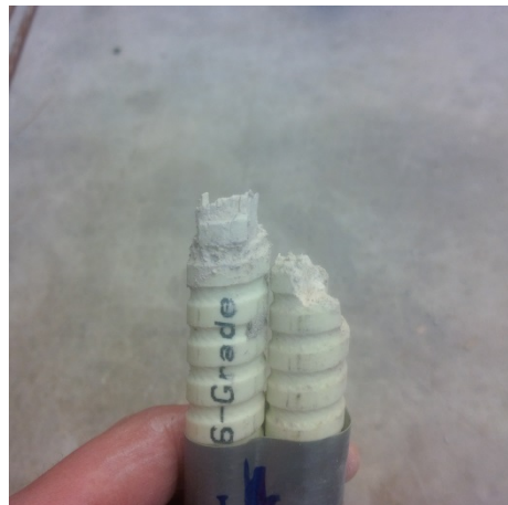
Figure A-54. RB-1: Bottom Bar #8 fracture plane.
