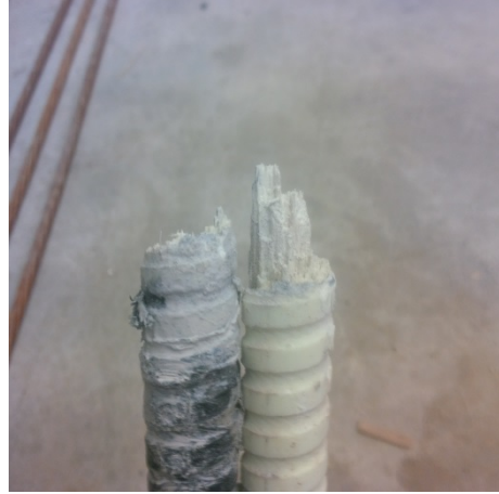
Figure A-52. RB-1: Bottom Bar #7 fracture plane.
