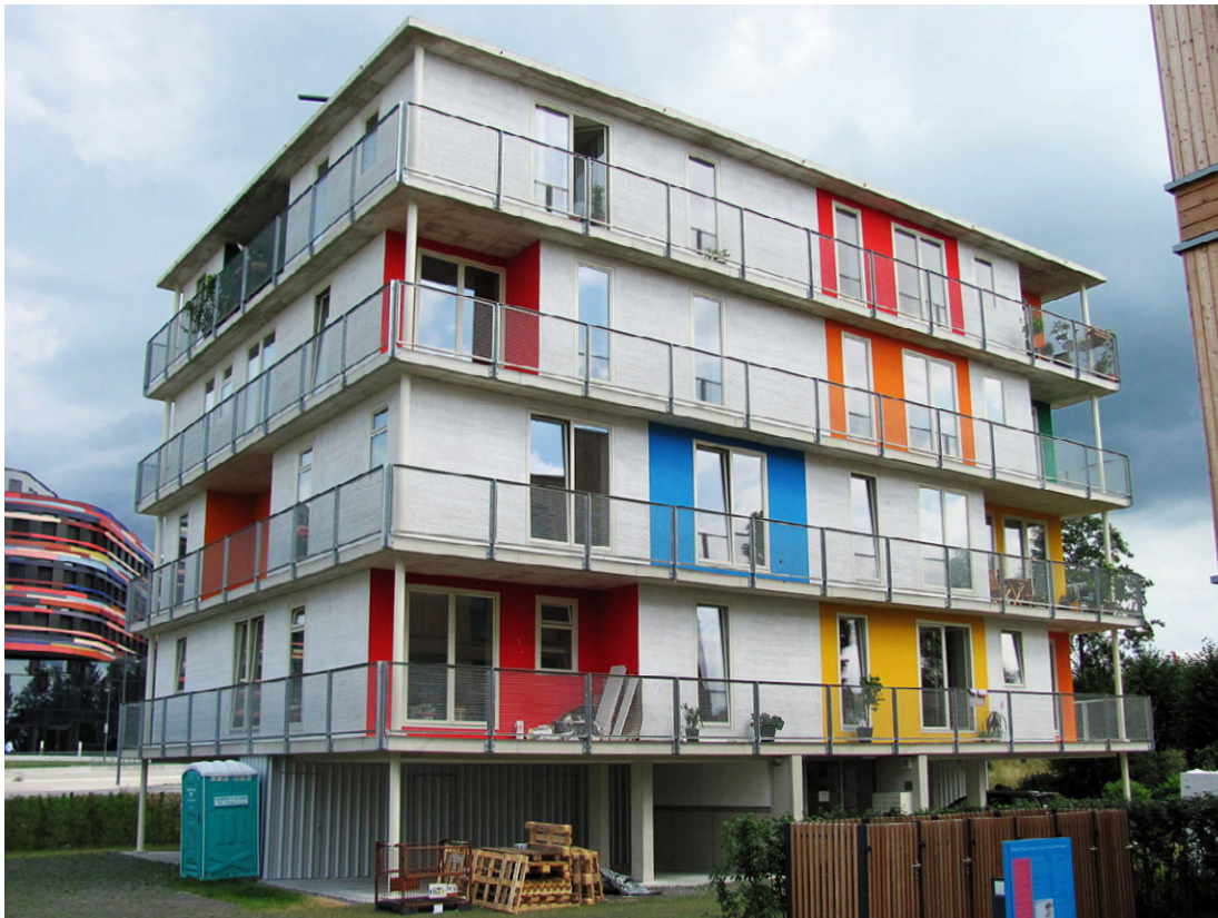
Figure 12.2 Grundbau und Siedler in Hamburg, 2013
