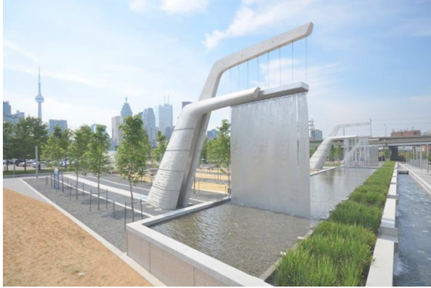
4.12 _ Sherbourne Commons Biofiltration Towers
