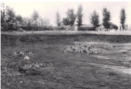
fig.4.9 EXCAVATION FOR VIA DI PORTA FURBA (1905)
