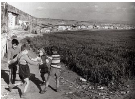
fig.4.31 BARACCOPOLI ALL'ACQUEDOTTO FELICE by Franco Pinna (1956)
