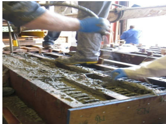
b- Concrete pouring
