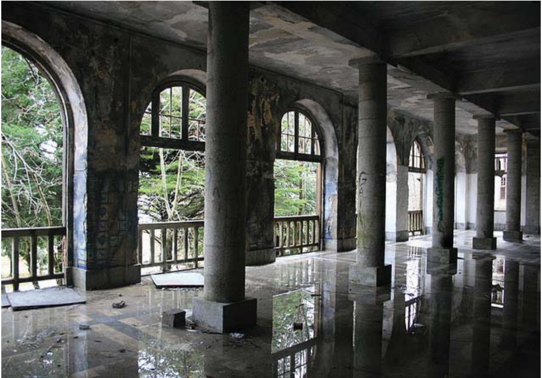
Figure 3.80: Hallway: Sanatório das Penhas da Saúde (2007).
