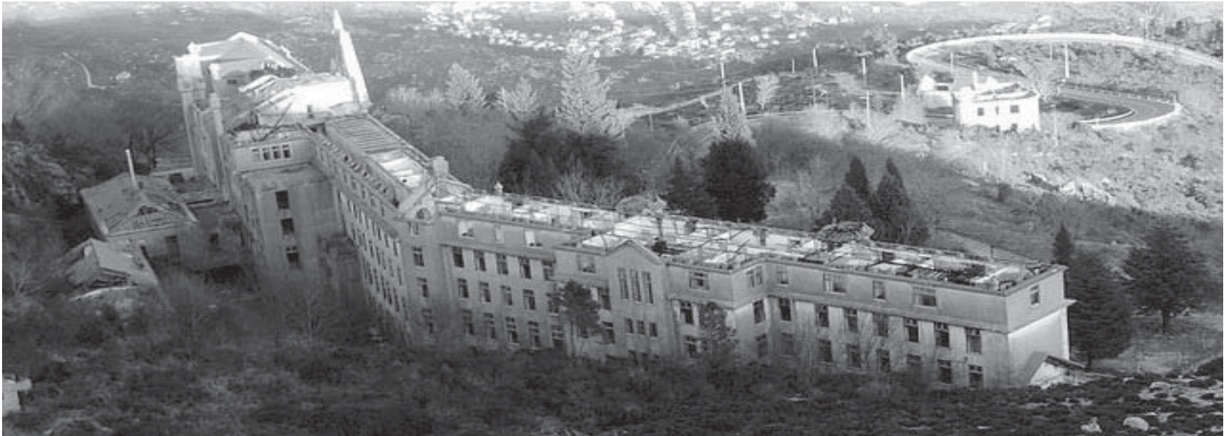
Figure 3.68: Sanatório das Penhas da Saúde (Sanatorium of the Rocks of Health) Covilha, Serra da Estrela.
