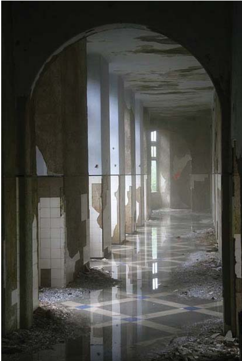
Figure 3.78: Hallway: Sanatório das Penhas da Saúde (2007).
