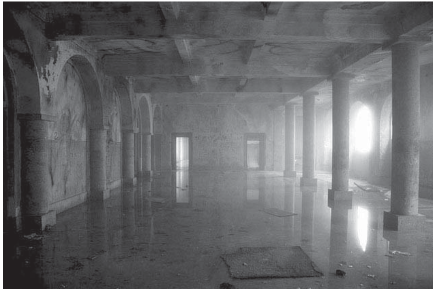
Figure 3.77: Hallway: Sanatório das Penhas da Saúde (2007).
