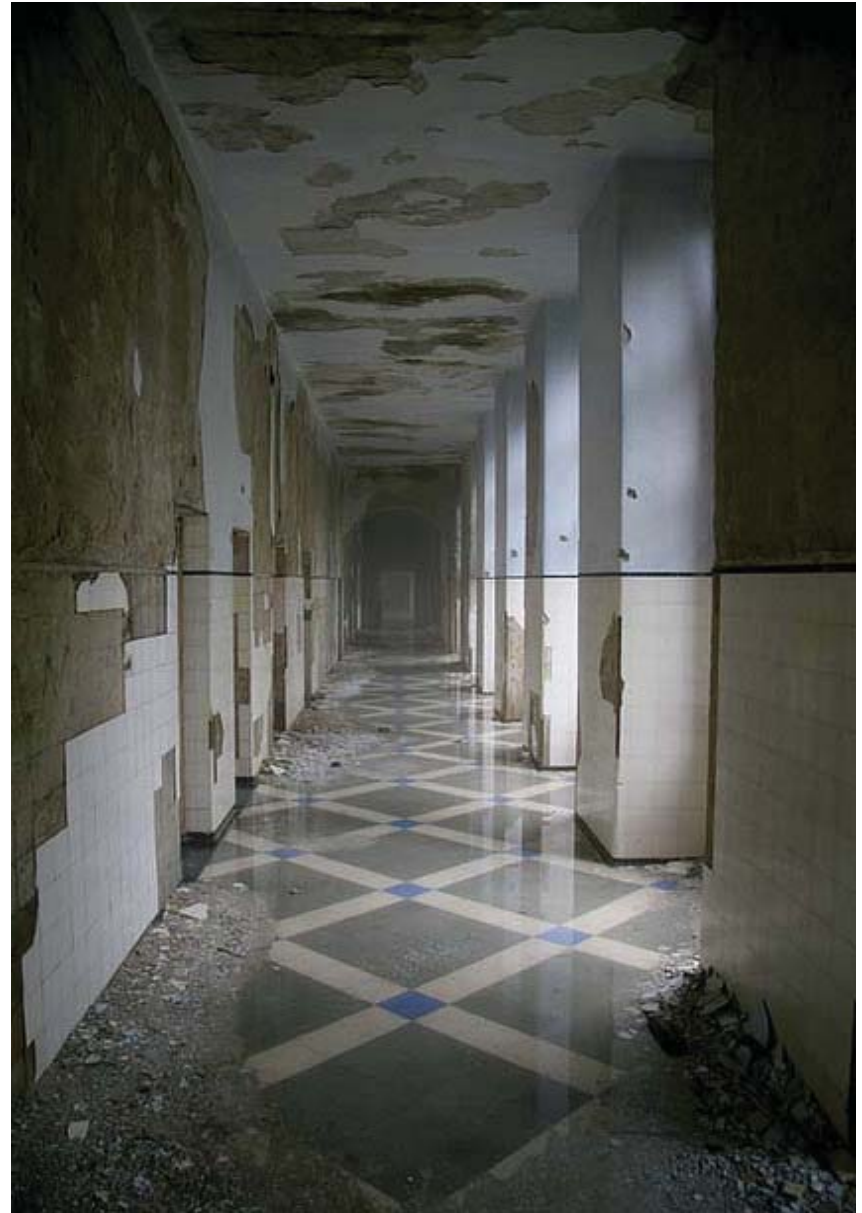
Figure 3.79: Hallway: Sanatório das Penhas da Saúde (2007).
