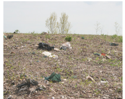
fig. 1.04 failing landfill cap
