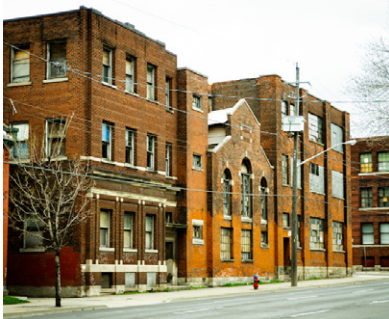
fig. 3.62 Cannon streetfront façade
