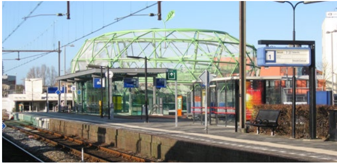
Figure 4-21 De Fietsappel exterior
